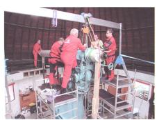
Fig. 10: Nach dem Entfernen des Objektivs begann die Demontage des Fernrohres. Dabei kamen, neben der detaillierten Registrierung, zahlreiche unentbehrliche Montagehilfen zum Einsatz. Aufn.: AW
