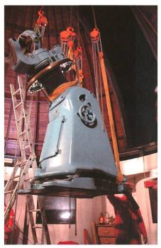
Fig. 14: Der Sockel, das schwerste Stück des Instrumentes, ist nur um Zentimeter schmäler als die Öffnung der Kuppel. Auch er konnte ohne Zwischenfall aus luftiger Höhe gehoben und zum Verlad und Abtransport bereitgestellt werden. Aufn.: Erwin Peter.
