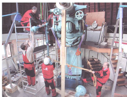
Fig. 9: Beginn der Demontage des Refraktors. In reiner Handarbeit und unter sorgfältiger Sicherung wurde die Montierung, deren Einzelteile teilweise mehr als 100 Kilogramm wiegen, abgebaut. Aufn.: AW
