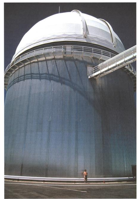
Fig. 14. La coupole du télescope de 3m60 (décembre 1986). Les télescopes modernes, bien que plus grands, occupent des coupoles moins volumineuses. Leurs montures azimutales et les techniques d'optique active autorisent des structures plus légères et compactes.
