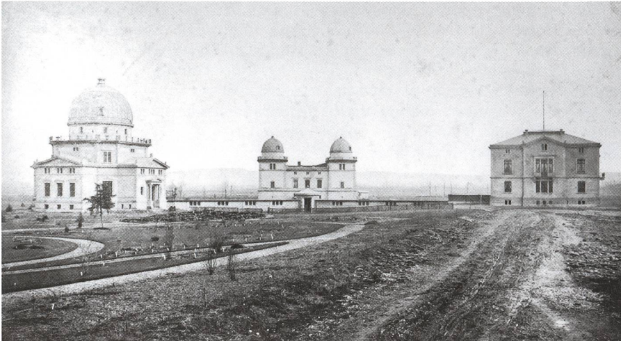
Fig. 5. Vue des bâtiments du Kaiserliche Universitäts-Sternwarte Straßburg (vers 1880). Quelques chemins et plantations naissantes du jardin botanique sont visibles au premier plan sur la gauche de la photo. Les traces de roues de charrette se dirigeant droit vers le bâtiment de droite (Bâtiment Sud) marquent la future Universitätsstraße. (Cliché Obs. Strasbourg)
