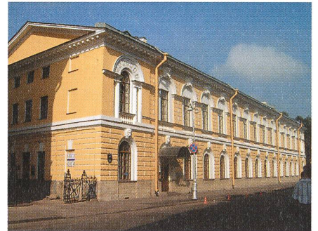
Fig. 14: Das Bibliotheksgebäude der Akademie der Wissenschaften. Obwohl das Äußere sehr schön restauriert wurde, sind die Verhältnisse im Innern des Gebäudes immer noch katastrophal. (Bild: A. VERDUN)
