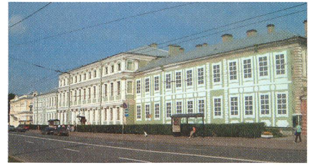
Fig. 13: Das Universitätsgebäude. Man beachte, dass die Fassade des rechten Flügels noch nicht restauriert werden konnte und daher mit einem bemalten Tuch verdeckt wurde. (Bild: A. VERDUN)
