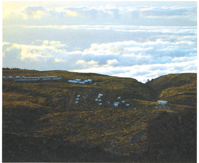
13. Le long bâtiment en arrière plan est l'hôtel de l'Observatoire avec, à sa droite, des entrepôts techniques. Au premier plan se trouvent les stations du réseau HERGA de télescopes de l'Institut Max Planck servant à détecter le rayonnement gamma d'origine cosmique, ainsi que le grand détecteur Tcherenkov actuellement en construction.
