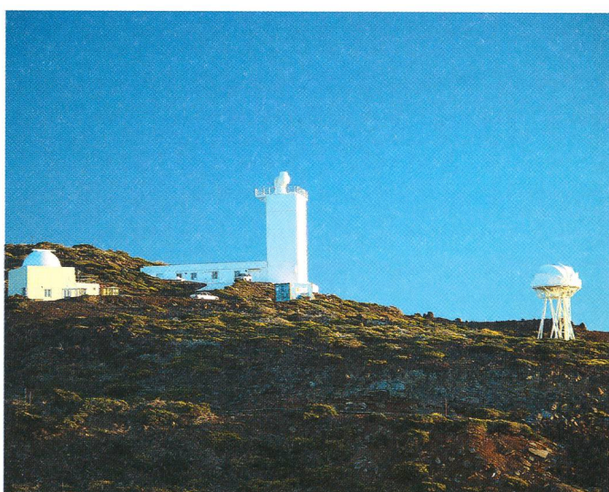
9. Les installations solaires suédoises et hollandaises. La structure du télescope hollandais, à droite, a des propriétés semblables à la monture Serrurier qui la rend moins sensible aux déformations induites par le vent.
