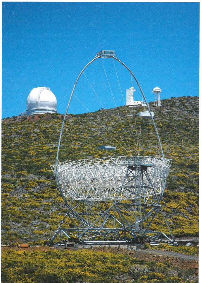
15. Le grand capteur Tcherenkov de rayonnement gamma cosmique de l'Institut Max Planck, en construction.
