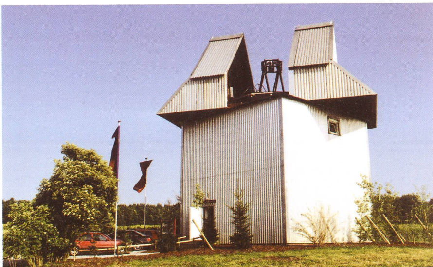
Fig. 1: Datei STW-B.JPG: Die aufgefahrene n Halften des drehbaren Daches geben einen Spalt von 4 Meter Breite für die Beobachter und das Teleskop frei.
