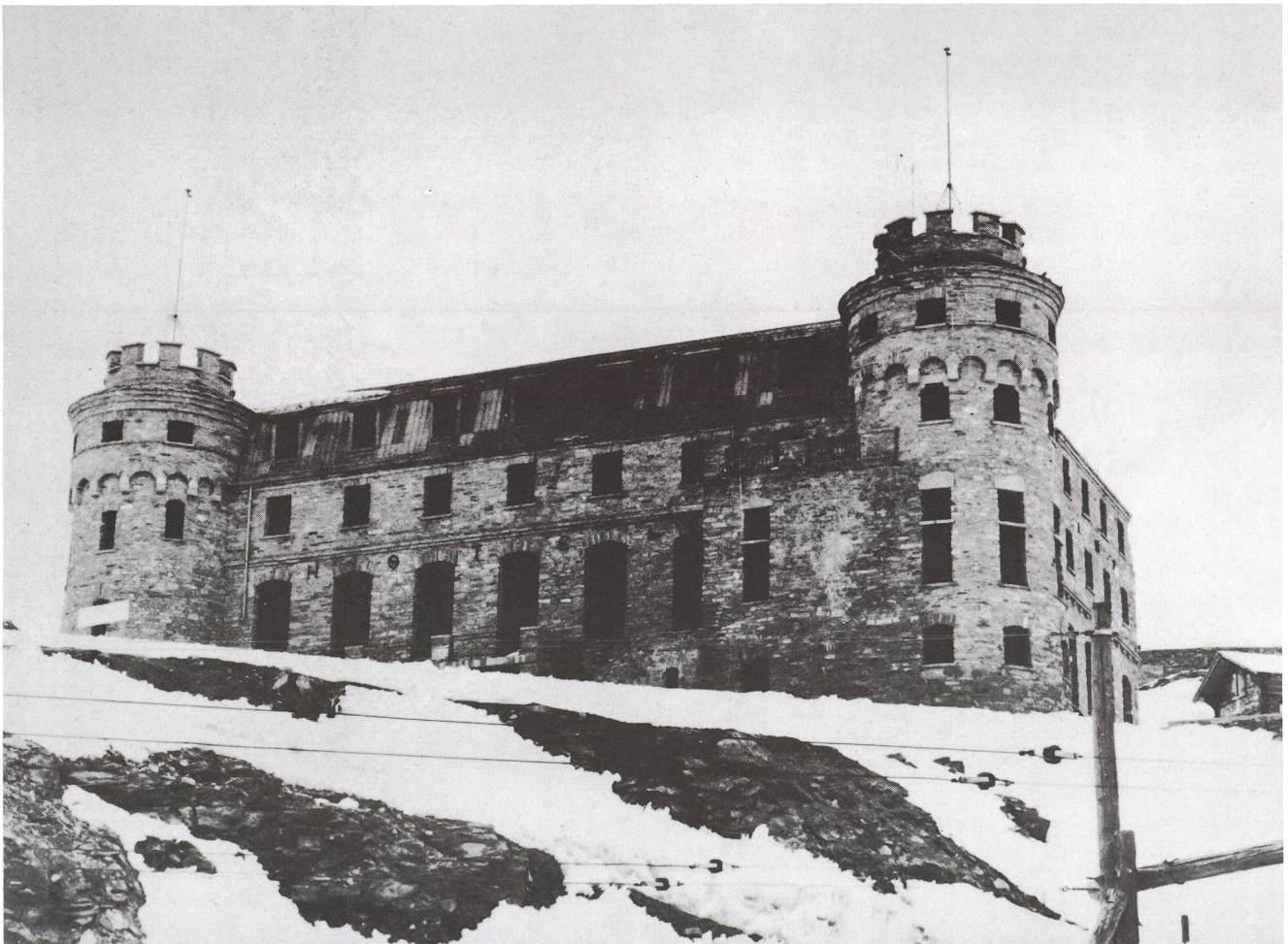
Abb. 1 Das Gornergrat Kulmhotel vor 1965 vom Gornergrat-Bahnhof aus gesehen. Im Vordergrund die Stromversorgung der Gornergratbahn.
