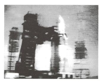
Bild l: Die startbereite Trägerrakete Energie auf dem Startplatz von Tyuratam. Um die riesige Zentral-stufe sind vier Starthilfe-Raketen angebracht. Die «Huckepacknutzlast» befindet sich auf der anderen Raketenseite.
