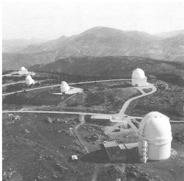
Das Deutsch-Spanische Astronomische Zentrum auf dem Calar Alto in Südspanien. Von links nach rechts: spanisches 1,5-m-Teleskop, 80-cm-Schmidt-Spiegel aus der Sternwarte Hamburg-Bergedorf, 1,23-m-Teleskop, 2,2-m-Teleskop und das 3,5-m-Teleskop, gefertigt von Carl Zeiss, Oberkochen (BRD).
