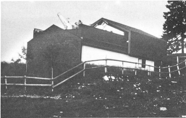
Abb. 1: Die Jurasternwarte mit abgefahrenem Dach und versenktem Westgiebel.
