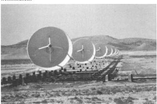
Abb. 9: Alle 9 Teleskope des Nord-Stranges schauen fast horizontal. Von der vordersten bis zur hintersten sind es 19 km! Gut sichtbar sind die beiden Schienenstränge, die Stumpengeleise und die Auflageböcke.
