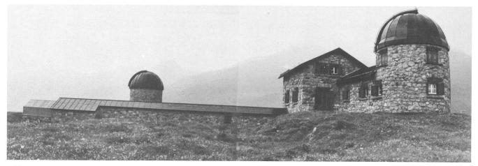
Abb. 1: Astrophysikalisches Observatorium Arosa Tschuggen der Eidgenössischen Sternwarte Zürich. Links: Abfahrbares Dach des Coelostraten des 30 m-Horizontal-Spektrographen. Die linke Kuppel enthält ein 15 cm-Coudé-Refraktor, die Kuppel rechts das Hauptinstrument.
