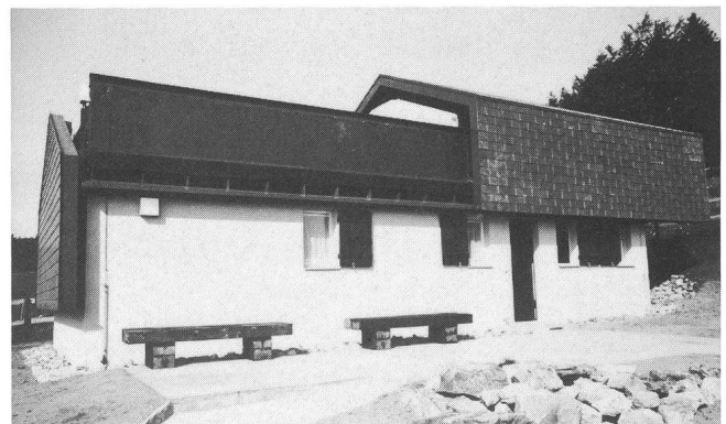
Die Sternwarte mit abgefahrenem Dach und versenktem Westgiebel. Ansicht von Süden.
