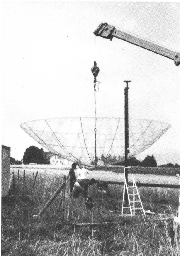
Fig. 1: Le réflecteur parabolique en cours de montage.
