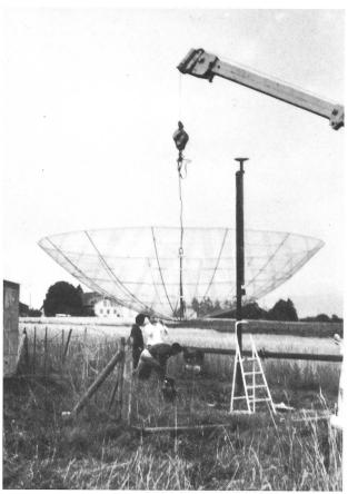
Fig. 1: Le réflecteur parabolique en cours de montage.
