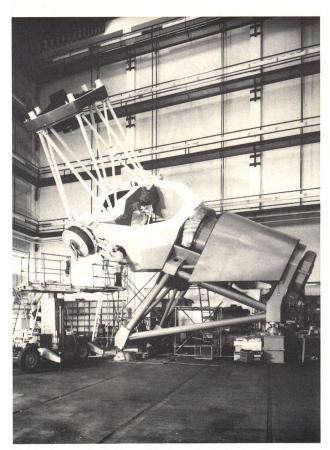
Fig. 2: Das zweite 2,20 m-Teleskop, das bei Zeiss für das Max Planck-Institut für Astronomie in Heidelberg gebaut worden ist. Das Teleskop soll auf der noch zu errichtenden Südsternwarte des Instituts aufgestellt werden.
