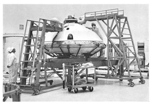
Abb. 1: Der Viking-lander bei seiner Ankunft am Ort seines Zusammenbaus mit dem orbiter. NASA-Photo 75-HC-52.
