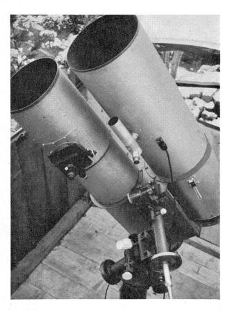
Fernrohre von Herrn J. LIENHARD aus Innertkirchen. – Das rechts abgebildete Teleskop, eine Schmidt-Kamera, hat in der Schweiz das grösste Öffnungsverhältnis, nämlich 1:1,6. Der Durchmesser der Korrektionsplatte beträgt 25 cm, die Brennweite ist 40 cm lang (R = 25 cm:40 cm = 1:1,6); der Spiegeldurchmesser misst 32,5 cm, der Netto-Filmdurchmesser 8 cm.
