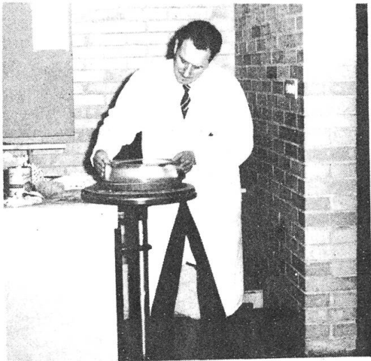
Abbildung 1: Unser Daniel van Kesteren beim Spiegelschleifen.
