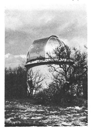
Figure 2: La coupole. On a conservé avec soin la végétation environnante pour éviter autant que possible les turbulences dues à l'échauffement diurne.
