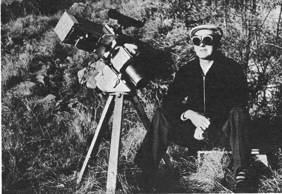
Abbildung 2 - 10 cm-Spiegelteleskop von 160 cm Brennweite, verwendet für Aufnahmen auf Monte Bignone, von W. Bohnenblust (siehe Text).
