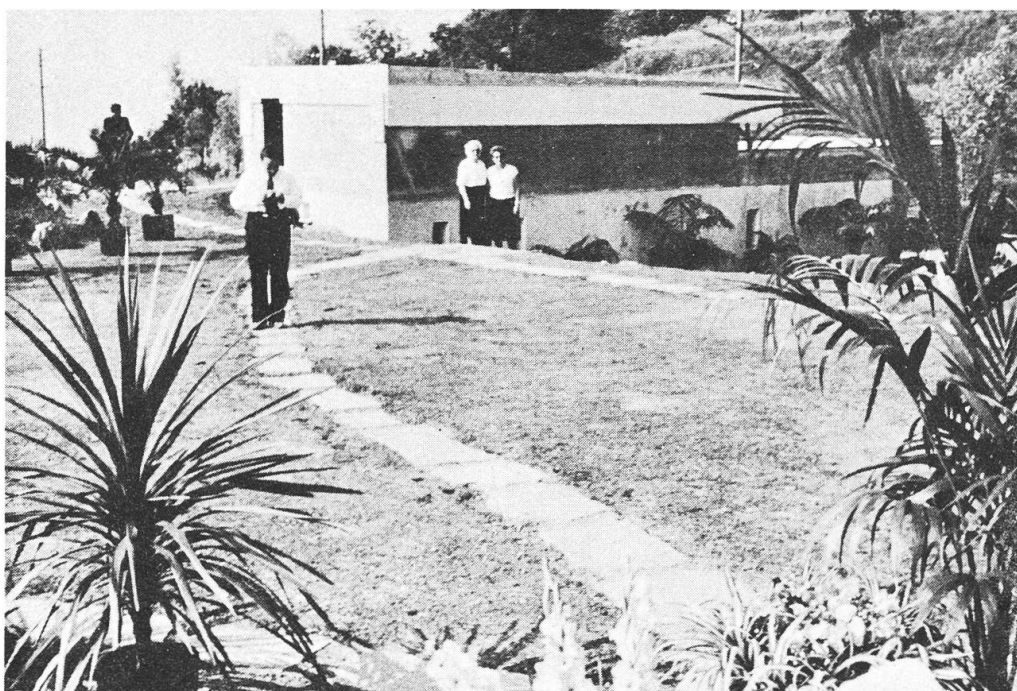
Abbildung 7 - Die Feriensternwarte «Calina» (geschlossen), mit abschiebbarem Flachdach. Im Untergeschoss ist das Photolabor und die Räume mit den Couchetten untergebracht; rechts ist die Garage angebaut. (Photo R. A. Naef.)
