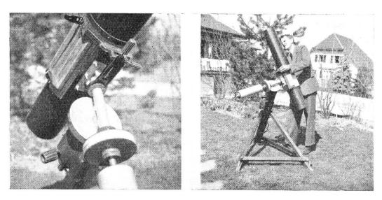
Abb. 1 und 2 Transportable Montierung mit Teilkreisen in Stunde und Deklination. Die Scheinerprobe erfolgt so, wie im Text beschrieben. Konstruktion: H. Suter, Ing., Wabern.
