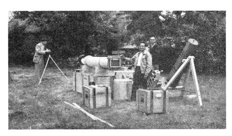
Abb. 13 Expedition der Eidg. Sternwarte Zürich, Gruppe auf Oeland. In der Bildmitte die horizontale Doppelkamera von 150 cm Brennweite mit Coelostat, rechts aussen feststehende Kamera mit 120 cm Brennweite, vorn Kinokamera. Von rechts nach links Dr. H. Bachmann, G. Widmer, R. A. Naef. (Photo Naef)
