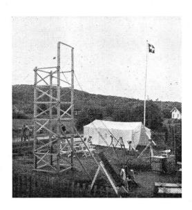
Abb. 11 Expedition der Eidg. Sternwarte Zürich, Gruppe Syd-Koster. Links der 7 m hohe Holzturm, der, an feinen Drähten aufgehängt, die Blende trägt, erforderlich für die Aufnahme der äusseren Korona mittelst Instrument in Bildmitte unten. (Photo Bär)
