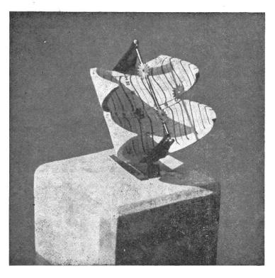
Abb. 5 Zylindrische Aequatorialdoppelsonnenuhr aus bemalter Eternitschale. Cadran solaire bi-équatorial de forme cylindrique en éternite peinte.
