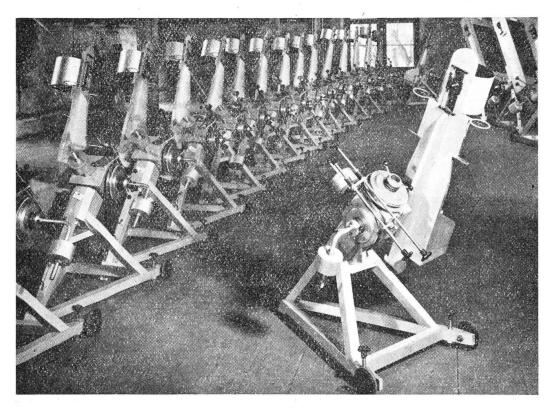
Montierung — bestimmt für den Einbau von 15 cm-Spiegeln — ist transportabel und mit Feinbewegung in Stunde und Deklination versehen.
