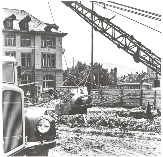
Bau der Unterführung unter dem Bahnhofplatz, 1951
