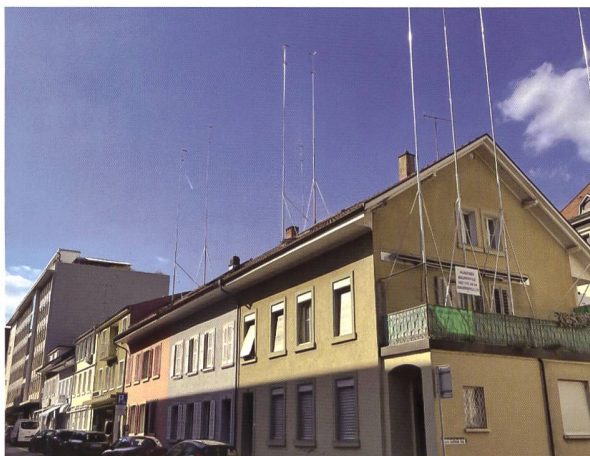
Die Innenentwicklung soll nicht nur die Profile in die Höhe wachsen lassen. Sie setzt hohe Anforderungen an die Qualität von Bauten und Freiräumen.
