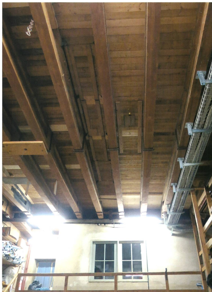
Bühnenkonstruktion Untersicht Holzbau
