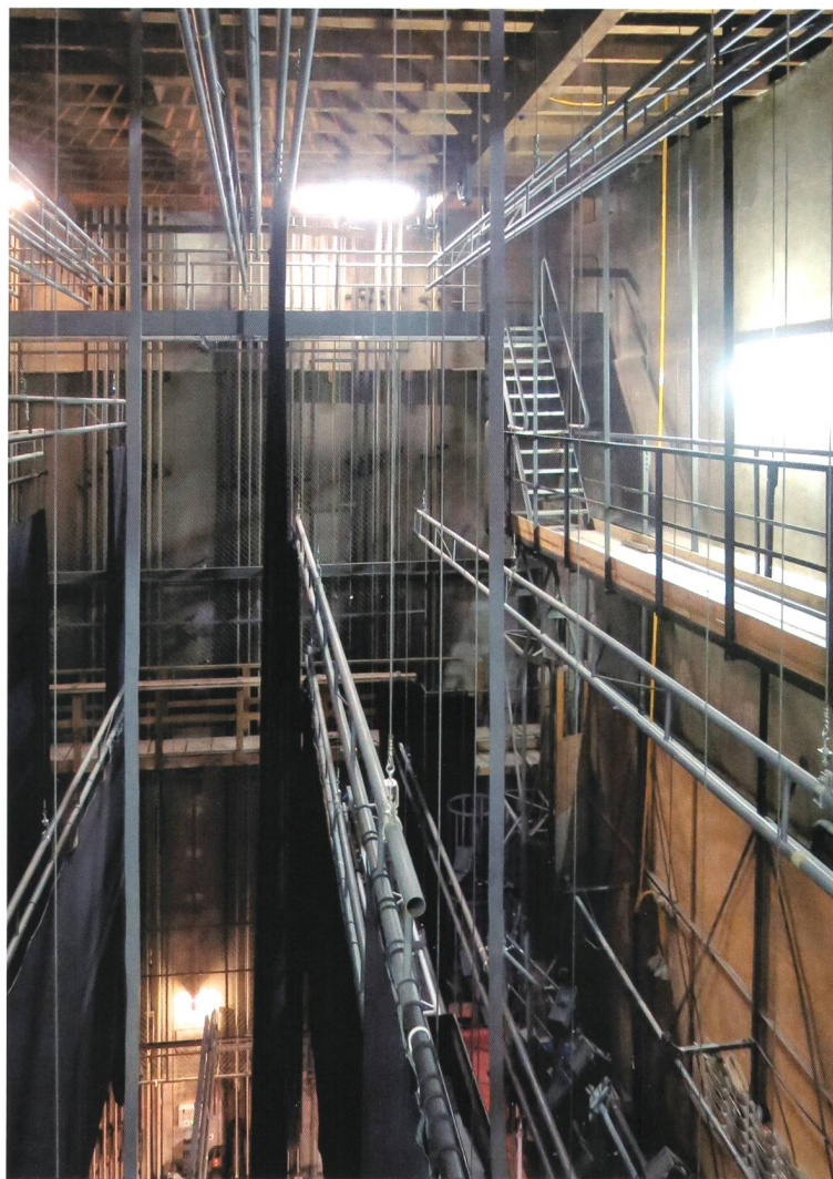
Arbeitsplatz über der Bühne und unter dem Schnürboden
