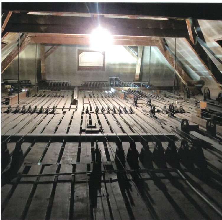
Der Schnürboden unter dem Dach
