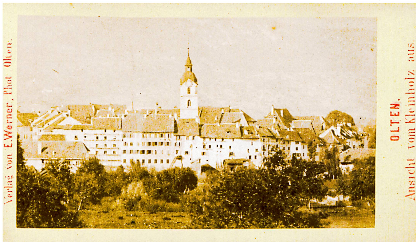
Emil Werner: Leporello Olten 1874: Blick von der Husmatt gegen die Altstadt. Von den drei wieder hergestellten Häusern (mit regelmässiger Fenstereinteilung) ist der Spittel noch eingerüstet.
