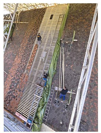
Die letzten Dachlatten sind erneuert, die Biberschwanzziegel können aufgesetzt werden. Wer kein Problem mit dem Gleichgewicht und die nötige Übung hat, findet auf den Holzlatten einen sicheren Halt.
