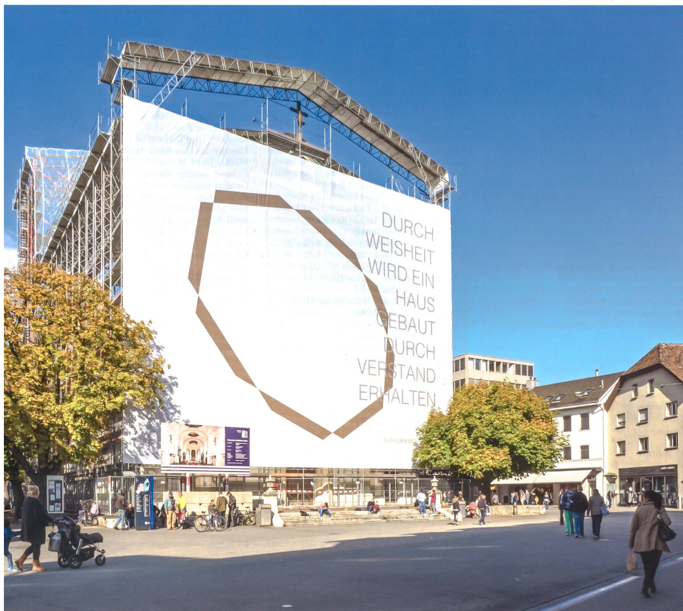
Die Stadtkirche eingerüstet zur Renovation
