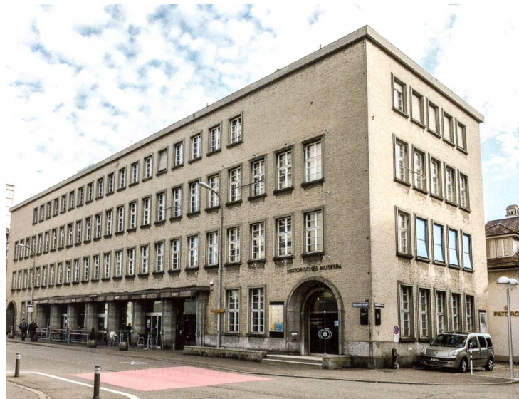
Das Gebäude an der Konradstrasse wird zum Haus der Museen.
