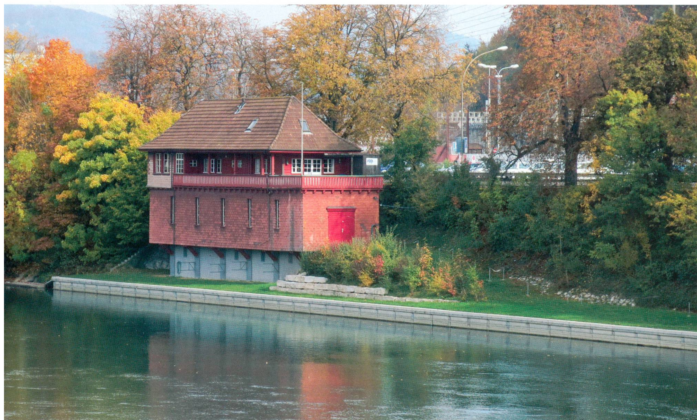
Bootshaus an der Gösgerstrasse – schönes Beispiel der Garten- und Bootshausarchitektur aus den Zwanzigerjahren mit eingefasstem Sockel- und ausgebautem Dachgeschoss. Die Terrasse in Richtung Norden ist zur Garderobe umgewandelt worden.
