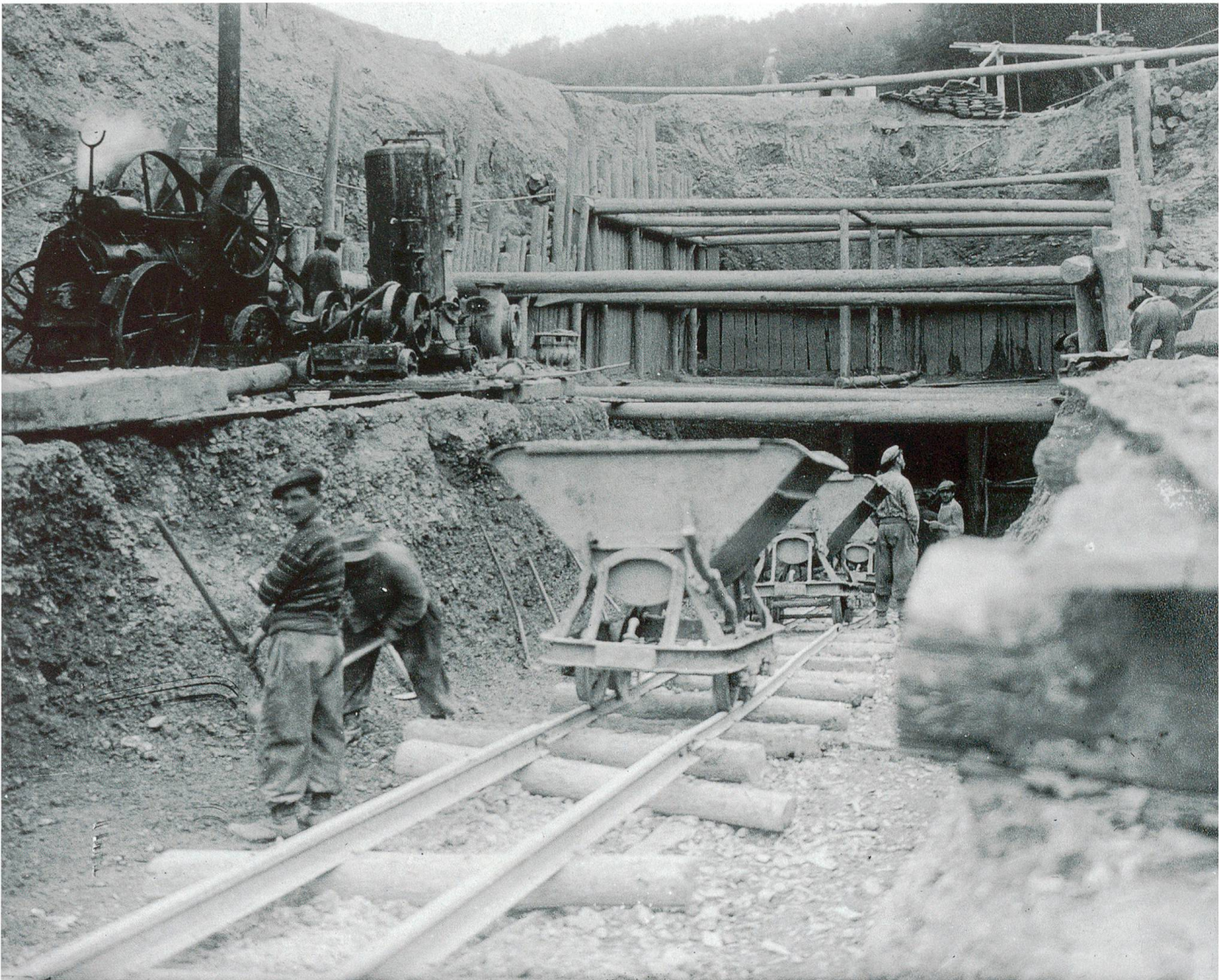
Beginn der Bauarbeiten zum Tunnel-Nordportal, das im Tagbau errichtet wurde. Kurz nach Erstellen des Leererüsts kam es im Oktober 1912 zu einem Erdbeben. Das Gerüst stürzte dabei ein.
