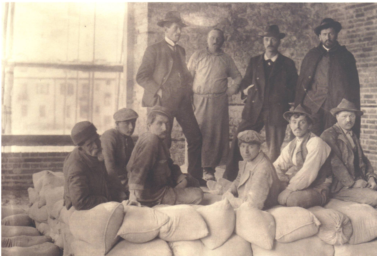
Italienische Cementiers des Bauunternehmers Walter Belart (4. v. l.), um 1910
