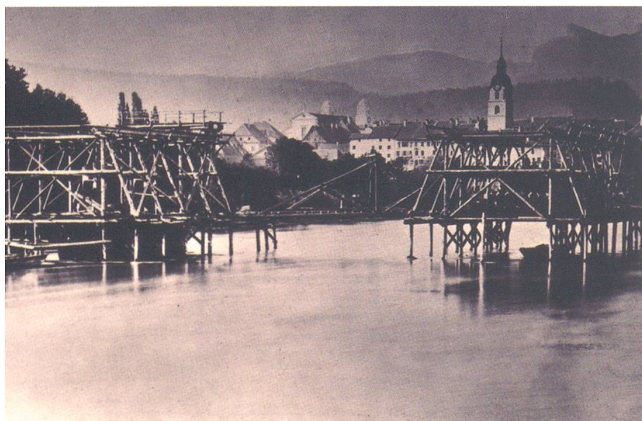
Gäubahnbrücke im Bau 1874. «An den beiden Wasserpfeilern an der Brücke in Olten, die ihre steinernen Köpfe aus dem Wasser hervorstrecken, wird rüstig fortgemauert, um das, was die Ungunst der Witterung und der andauernd hohe Wasserstand verzögerten, wieder einzubringen, damit noch im Spätsommer dieses Jahres die Lokomotive den Gäuern ihren schrillen Gruss bringen kann.»
