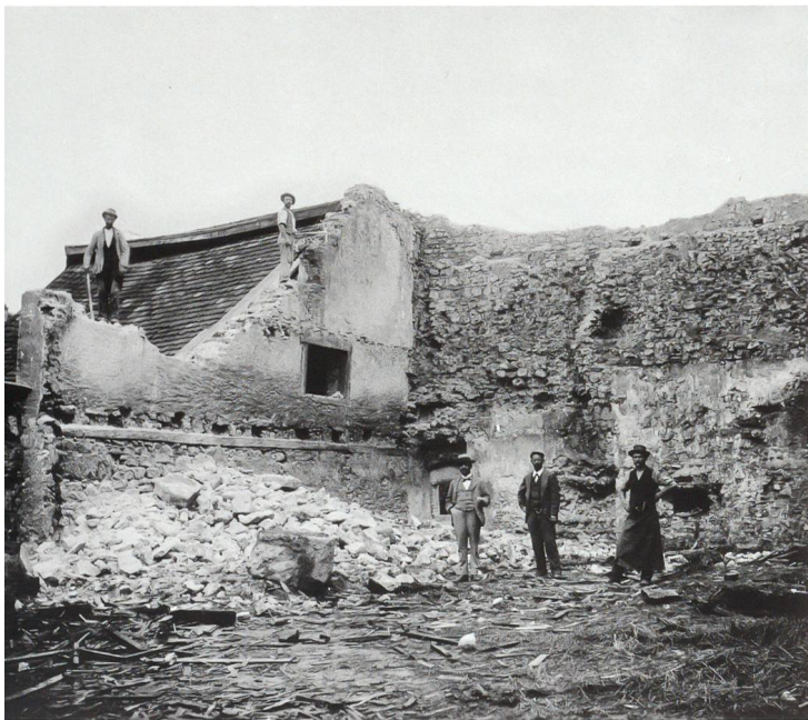
Abbrucharbeiten von 1902/03 an der alten Ringmuer, bevor unser Haus, Klosterplatz 7, gebaut wurde
