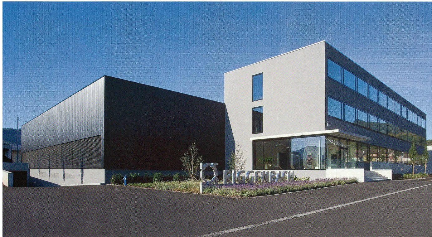
Das neue, von der W. Thommen AG erstellte Büro- und Produktionsgebäude an der Werkhofstrasse, nach dem Minergiestandard konzipiert
