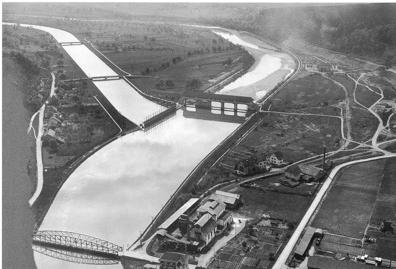
Der korrigierte Aarelauf mit den Einlaufschleusen oberhalb des Hauptwehrs. Im Vordergrund das Gaswerk Rothenbach, das 1912 errichtet wurde und 1945 von der Stadt Olten übernommen wurde.
