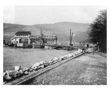
ausgenützte Flussstrecke beginnt unterhalb der Brücke bei Aarburg und endet ca. 300 m oberhalb der Brücke bei Schönenwerd, wo der Unterwasserkanal in die Aare fliesst. Die ganze Strecke misst etwa 14 km, das Gefälle beträgt rund 18 m.
