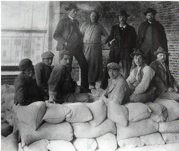
Betonieren der Bodenplatte und Belastungsprobe durch Maurer der Firma Belart
