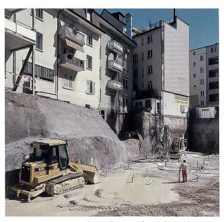
Sprengungen mitten in Olten – die Baugrube wird ausgehoben.
