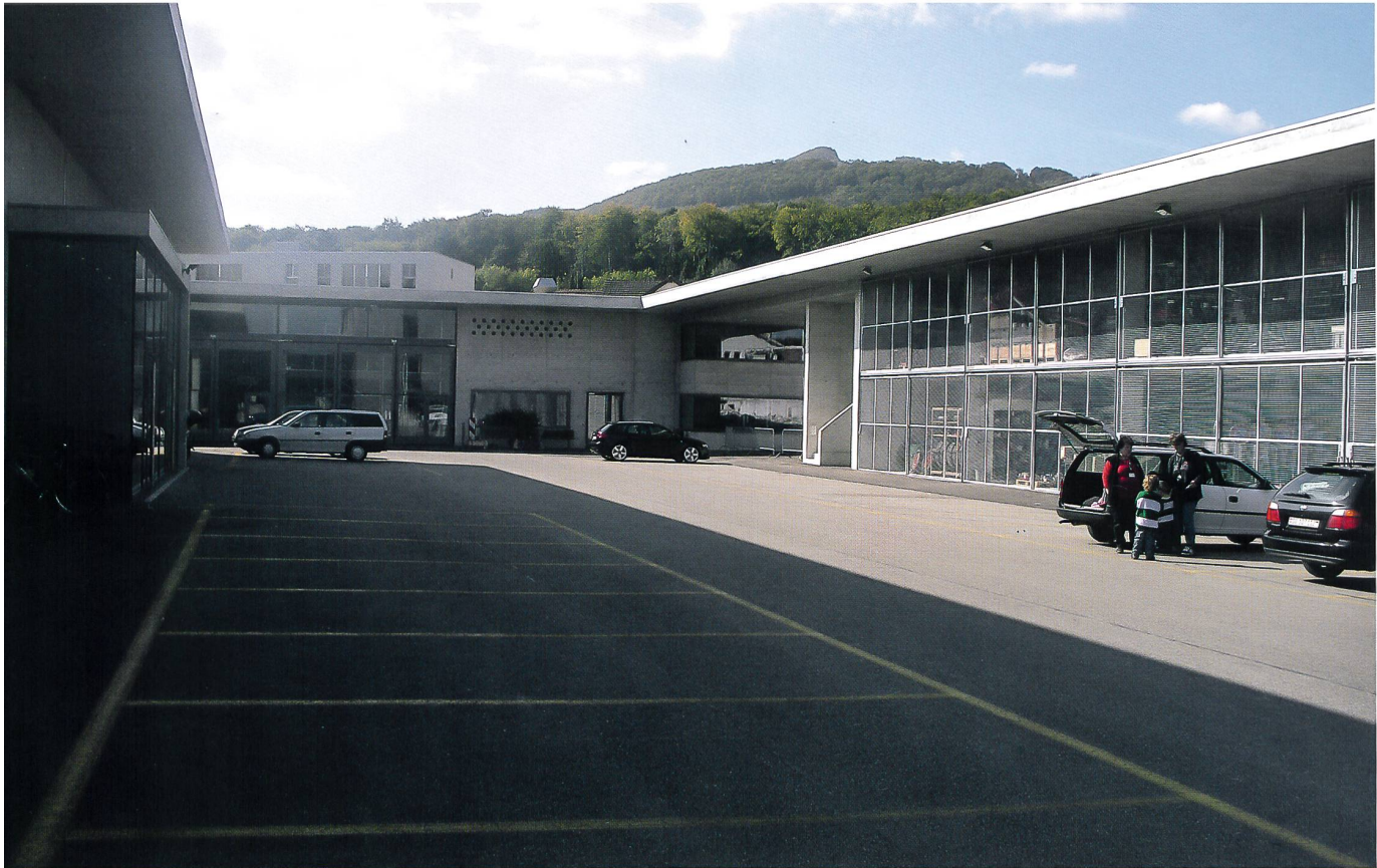
Neubau Werkhof unmittelbar neben dem Feuerwehrmagazin
