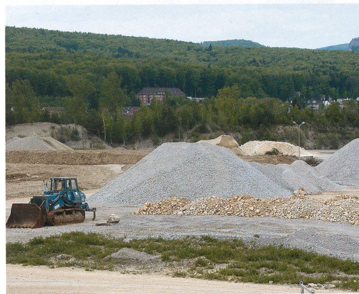
Impressionen vom Rückbau 2005
