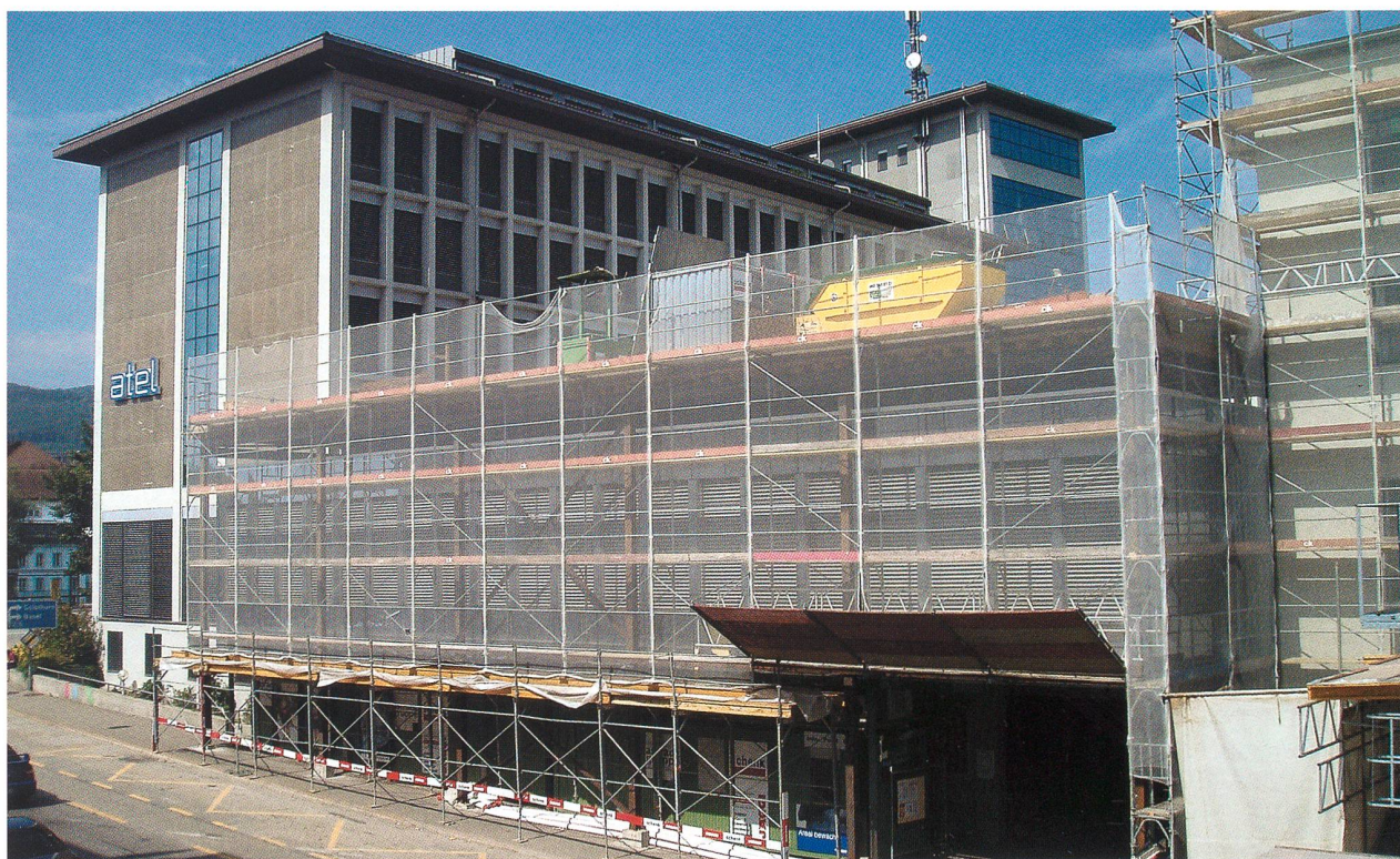
Am Atel-Hauptsitz in Olten entsteht unter anderem ein neuer Trading-Floor für den Energiehandel.
