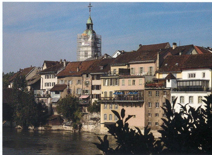
Renovation des Stadtturms
