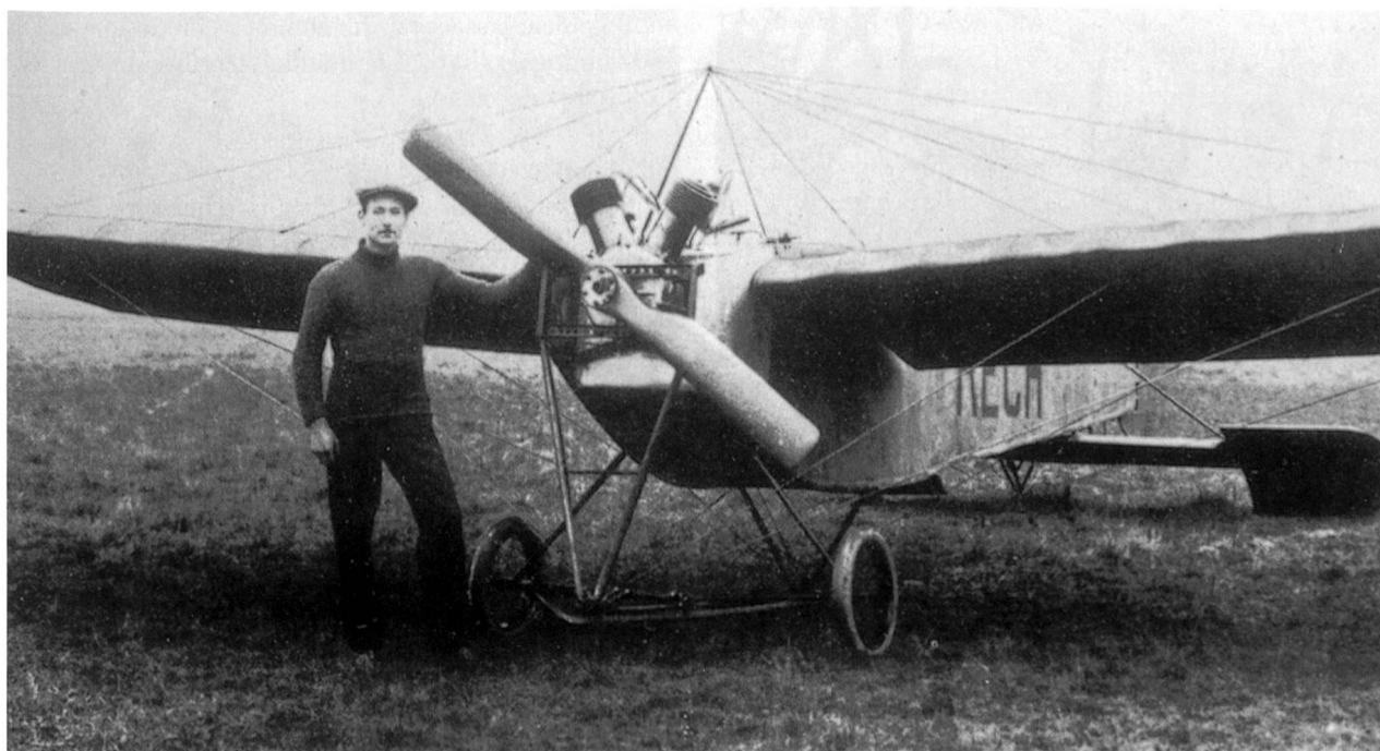
Ernst Rech vor seinem selbst gebauten Eindecker mit Anzani-Motor
