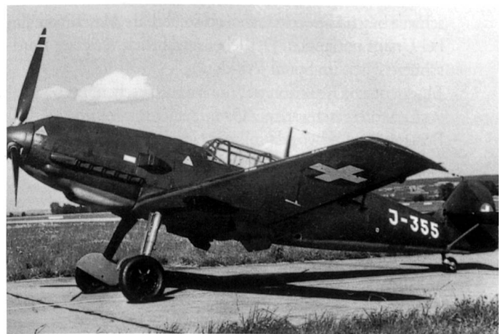
Der Messerschmitt-Me-109 E-Jäger, in der Schweiz genannt Me 109 DB. Deutlich erkennbar das schmale am Rumpf befestigte Fahrwerk. Bewaffnung: 2 MG, 2x20-mm-Oerlikon-Flügelkanonen. Geschwindigkeit 450 – 570 km/h.
