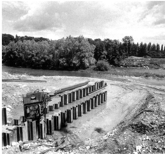
Der Neubau des Dükers im Haslgebiet
