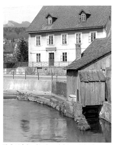
Wie diese Aufnahme schön zeigt, wurde die innere Bleichewalke im Hammer ebenfalls durch ein unterschlächtiges Wasserrad angetrieben.
